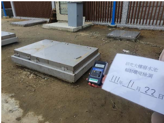
監測項目：環境輻射(111年第4季) 監測地點：廢水槽1-2一樓上方處
