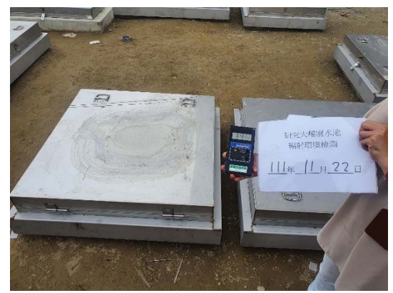
監測項目：環境輻射(111年第4季) 監測地點：化糞池一樓上方處
